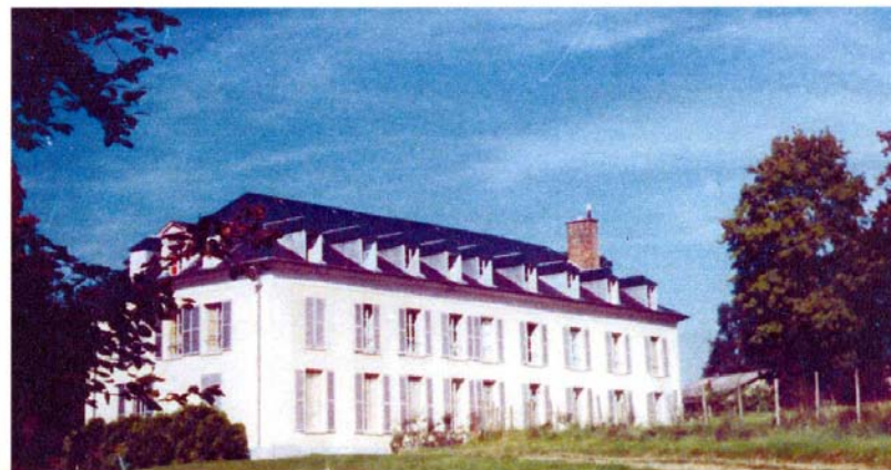
Bâtiment Notre-Dame, datant du 18 e siècle
