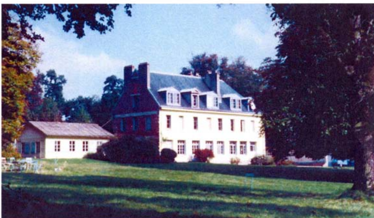
Bâtiment St-Joseph, datant de 1950
